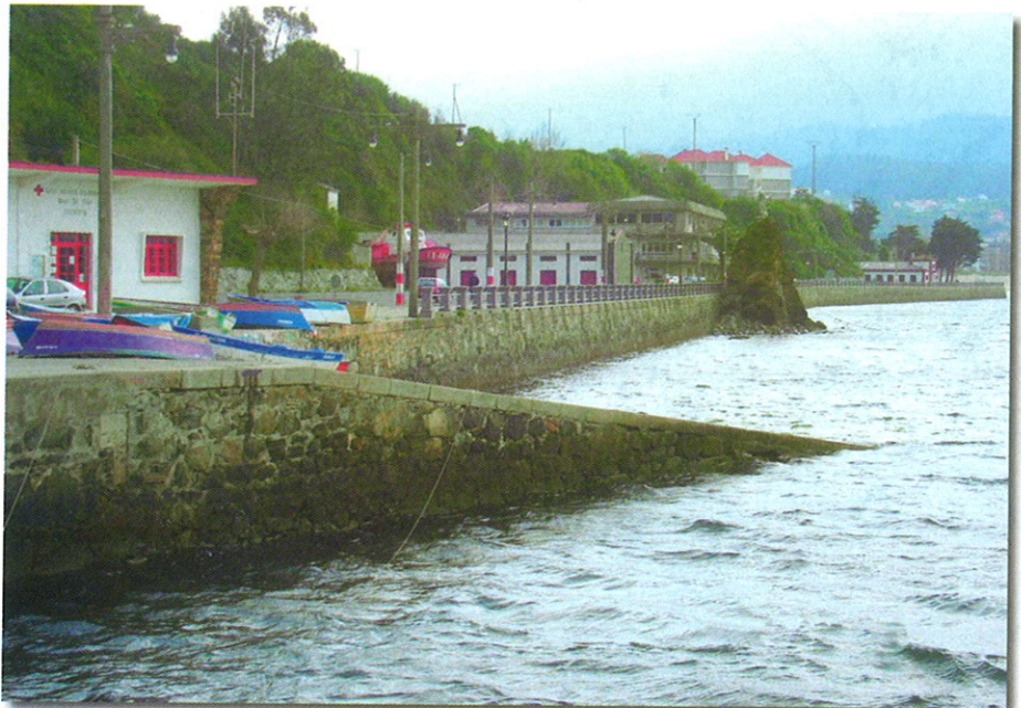
Actual rampa de varado de pequenas embarcacións
